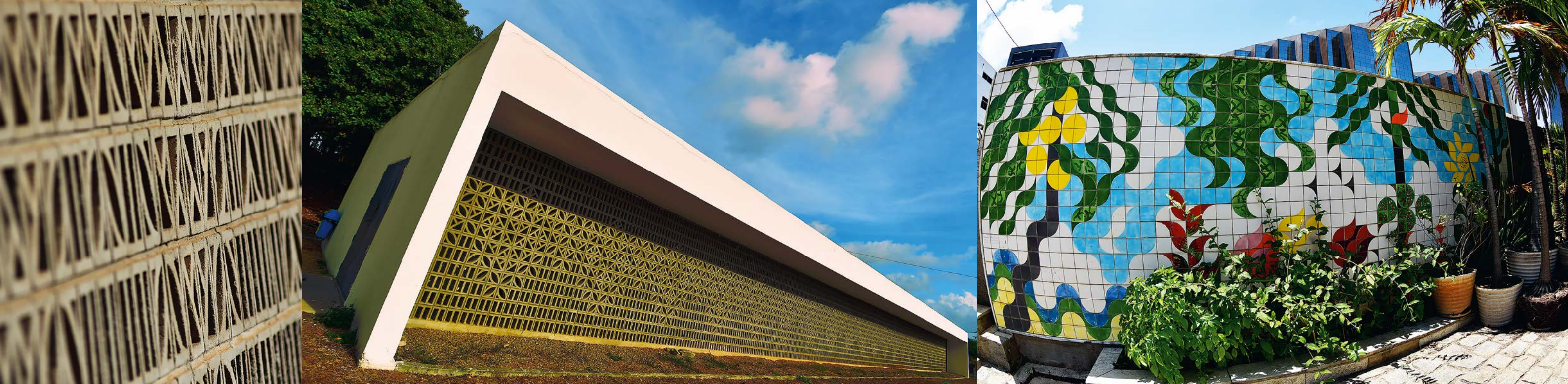
Painel de cobogó Varanda de rede foi encomenda de Oscar Niemeyer, com 40 metros de largura; e painel de azulejos instalado em galeria de rua de João Pessoa
